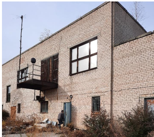
Здание СОЖ – не действующее.
